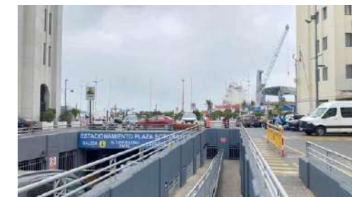
Ingreso a estacionamientos subterráneos.
