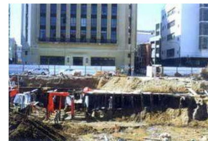
Construcción estacionamientos subterráneos.
