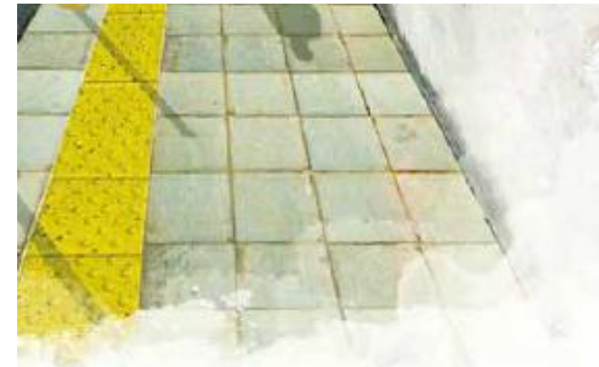
Franja con pavimento de alerta ubicada adyacente a la línea imaginaria que conforman los bolardos, por el lado que corresponde a la acera
