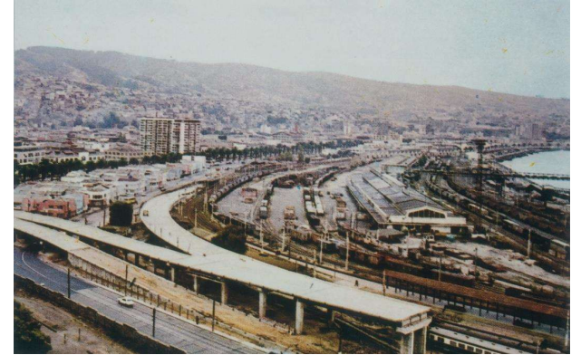
Infraestructura portuaria y ferroviario - 1960
