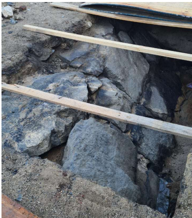
Enrocado protección costera 1851
